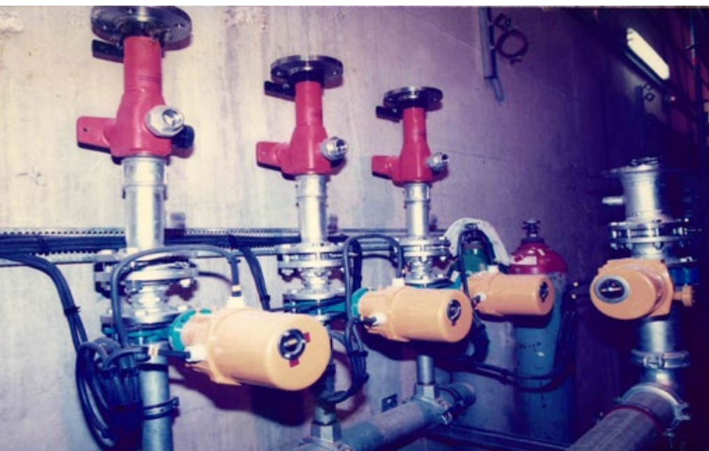
Départ extinction incendies des trémies de chargement
